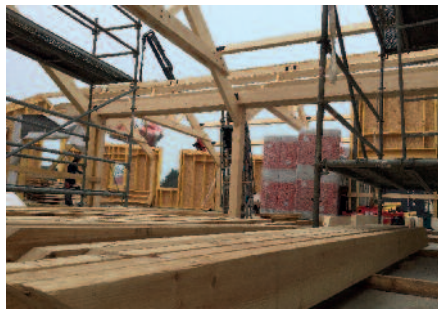
Les travaux d'extension de la Maison Médicale.
