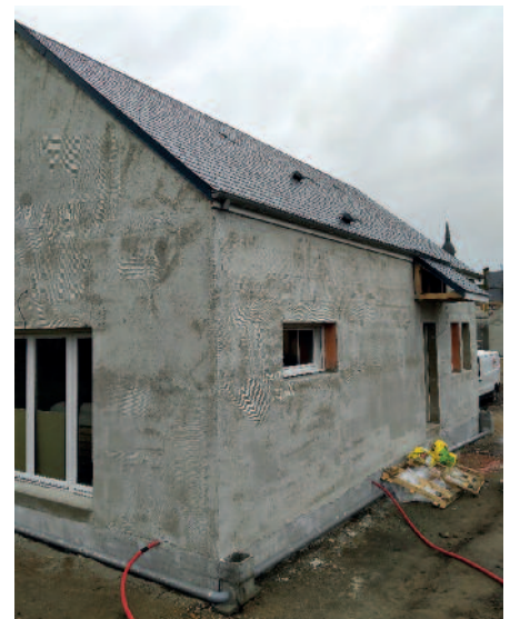
Les logements Cours du Louvre et du Croissant en construction.
